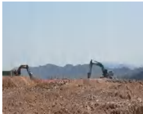
项目东北面--空地
